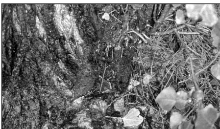
Strom poškodený hýfmami mycélia drevo-kazných húb, drevokazných mravcov. Poškodený je aj kmeň rozsiahlou dutinou. Podľa znalca tu po rozmočení pôdy hrozí náhle vyvrátenie kmeňa. Odporučil ho preto vyrúbať.
