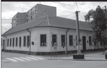
Budova Slovenskej pošty na Bratislavskej č. 1. Patrí k pôvodnej zástavbe námestia. Rovnaký štýl architektúry má aj budova Správy cestovného ruchu na Mierovom námestí č. 19. Budovy patria k posledným stavbám svojho druhu v Senci.
