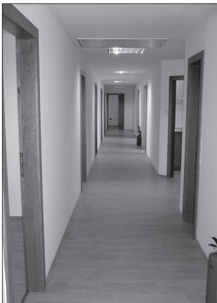
V nadstavbe je 14 nových kancelárií.
