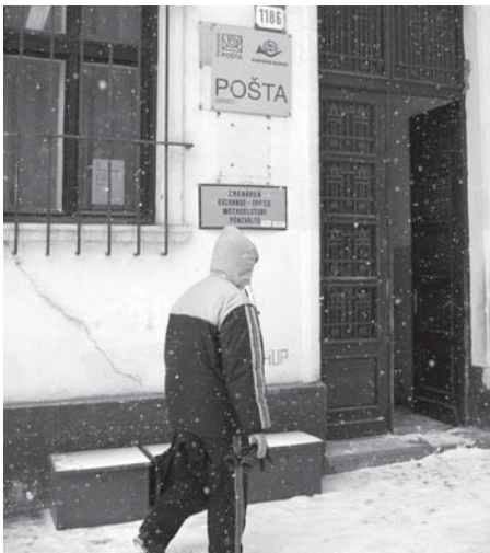
Zamrežovaná nevzhľadná budova pošty je päsťou na oko rozvíjajúceho sa Senca.
