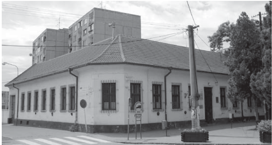
Hendikepovaných nosia na pošte na rukách. Chýba bezbariérový vstup, za vstupnými dverami sú ďalšie schody.
