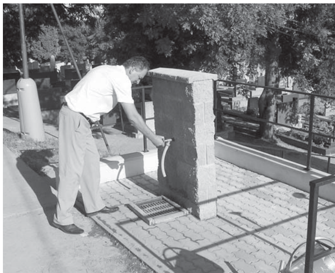
Na polievanie slúžia na cintoríne vodovodné vývody.
