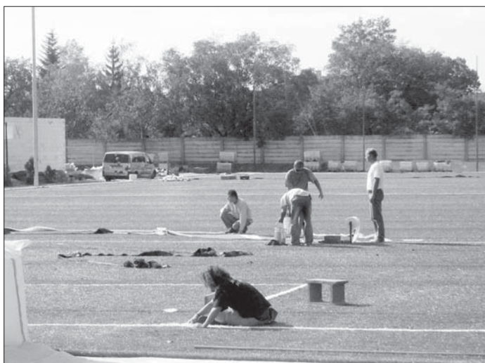
Umelý trávnik vo Veľkom Bieli je pred dokončením.
