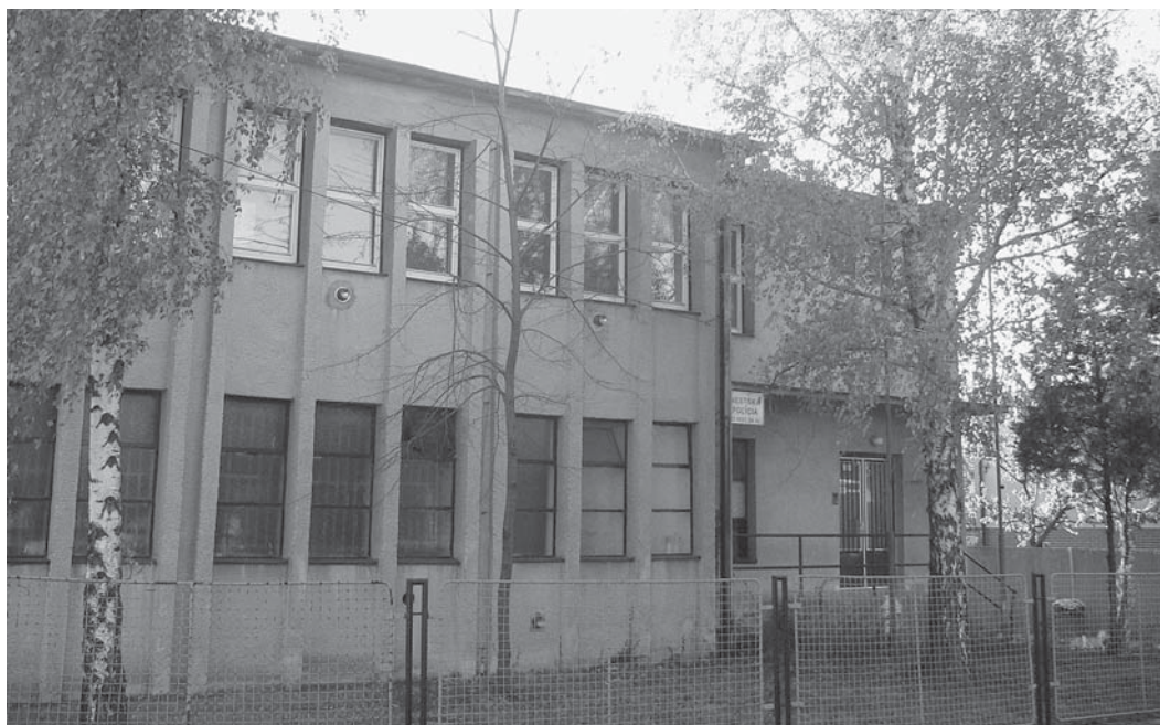
Budova mestskej polície na Kalinčiakovej ulici
