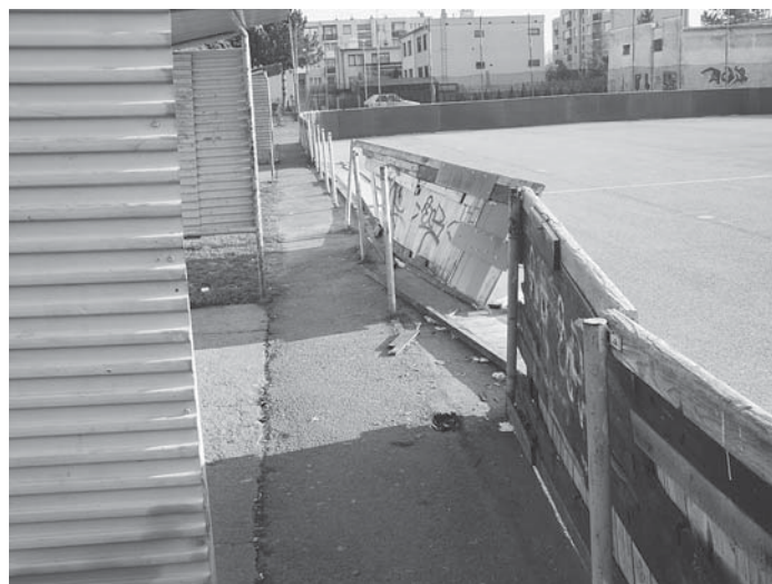
Na obrázkoch sú poškodené mantinely na hokejbalovom ihrisku v Senci. Vandali zničili prácu tých, ktorí majú radi šport a snažia sa ihrisko udržiavať v použiteľnom stave. Pripravili im ďalšiu robotu.
