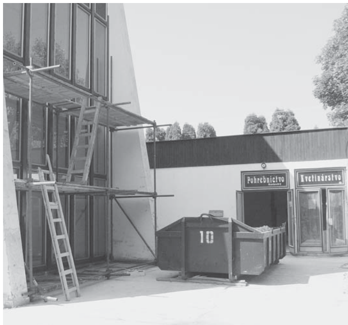
Rekonštrukcia Domu smútku má byť dokončená do konca roka.
