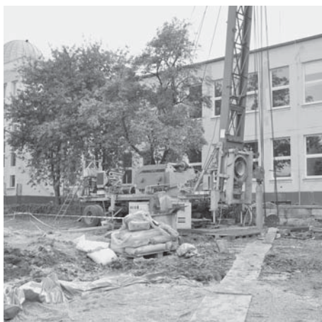
Zemné práce pri maďarskej základnej škole súvisia s výstavbou studne na zavlažovanie Farského námestia. foto Ján Lauko
